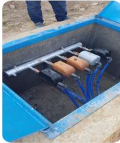
Kozaklı İlçemize bağlı Küllüce köyümüzde şebeke hattının yenilenme çalışması yapılmıştır.
